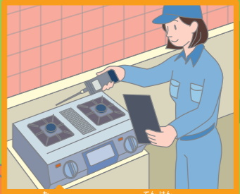
漏れていないか点検する
