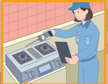
漏れていないか点検する
